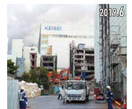
解体工事の開始
