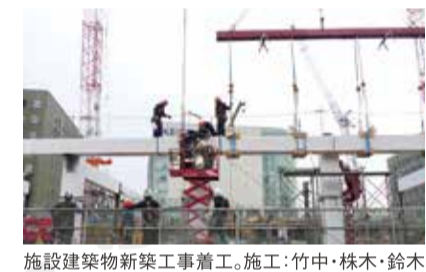
施設建築物新築工事着工。施工：竹中・株木・鈴木・葵・関根 特定建設工事共同企業体
